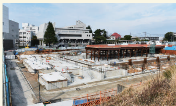
建設中の新室内プール(2020年3月現在)
